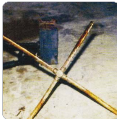
Step 12 용접 완료 상태
